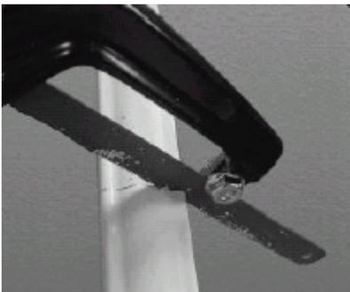
La canaleta siempre has de cortarla con la tapa puesta. De esta manera tendrá más consistencia y te evitas tener que realizar dos cortes por separado, uno para el cuerpo de la canaleta y otro para la tapa.
