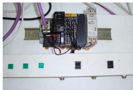
la realiza una fuente de alimentación Omron S8VS de 24 Vcc y 30 W. (Como elemento adicional en el bus se utilizan dos entrenadores de PLC con CPU CJ2W31 provistos de una unidad esclava PRT21).
