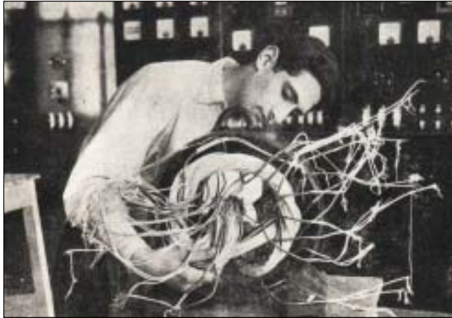
Bobinando un estator con hilo forrado de algodón
